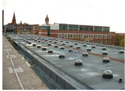
Figura 8.4 Utilizarea combinată a luminii electrice și a tuburilor de lumină pentru o clădire de birouri [2]
