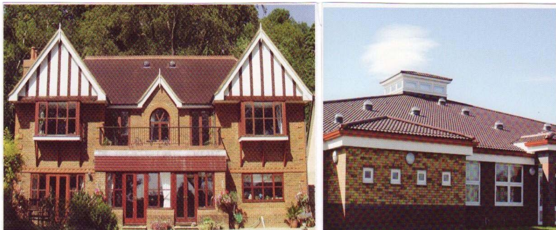
Figura 16 Clădiri echipate cu tuburi solare
